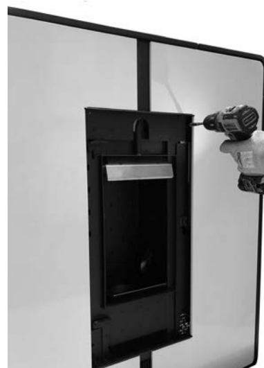
Fig. 52 - Fixation du revêtement
