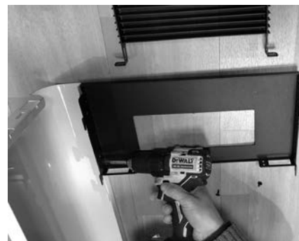
Fig. 30 - Fastgør pladen til beslaget
