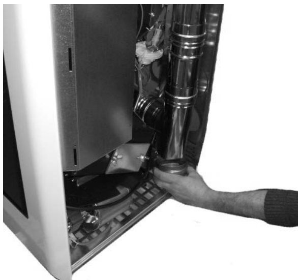
Fig. 102 - Limpeza do canal de fumo
