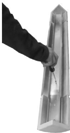
Fig. 34 - Aparafusar o perfil nas majólicas
