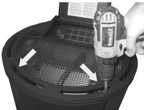
Fig. 81 - Remoção dos parafusos tampa 1
