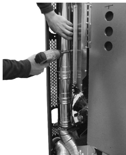
Fig. 64 - Fixação do tubo
