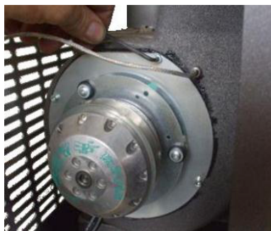
Fig. 47 - Nettoyage de l'aspirateur des fumées: phase 1
