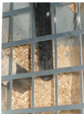
Fig. 42 - Nettoyage réservoir et vis sans fin
