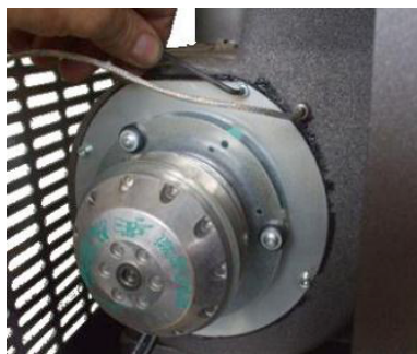
Fig. 47 - Pulizia aspiratore fumi: fase 1
