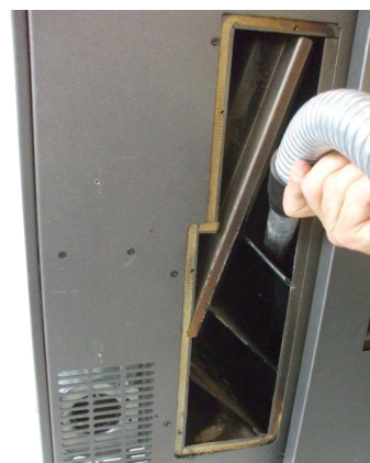
Fig. 45 - Nettoyage de la chambre des fumées
