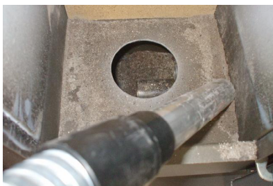
Fig. 39 - Pulizia vano cassetto cenere
