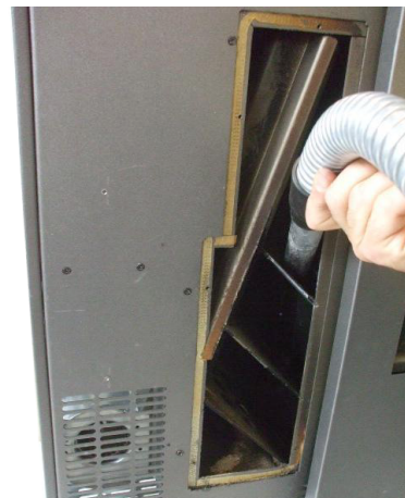
Fig. 44 - Limpeza da câmara de fumos
