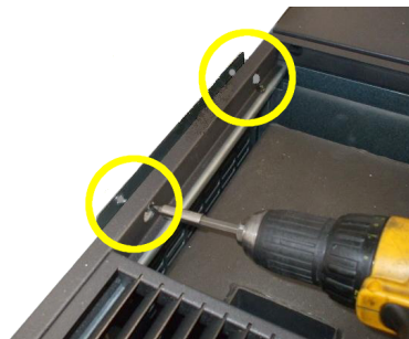
Fig. 18 - Fixação na parede
