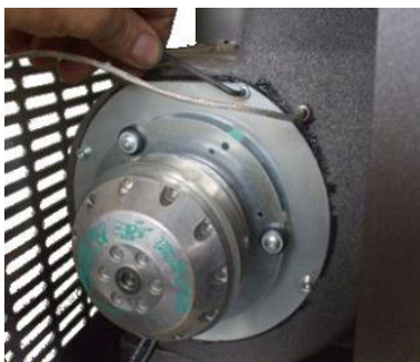
Fig. 46 - Pulizia aspiratore fumi: fase 1
