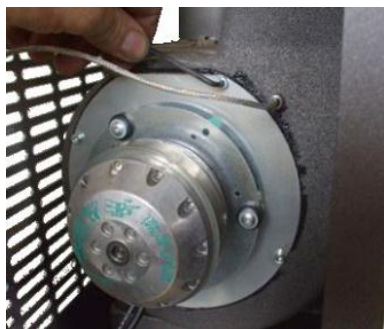
Fig. 46 - Nettoyage de l'aspirateur des fumées: phase 1
