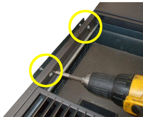
Fig. 18 - Fissaggio al muro
