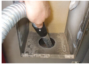
Fig. 38 - Nettoyage l'espace du brasero
