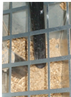
Fig. 40 - Nettoyage réservoir et vis sans fin
