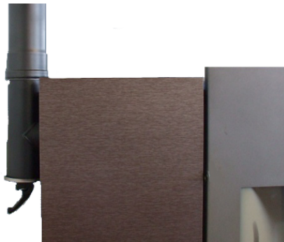
Fig. 45 - Nettoyage du conduit de fumée
