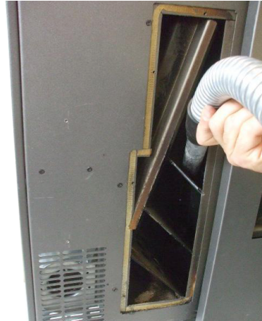
Fig. 44 - Nettoyage de la chambre des fumées
