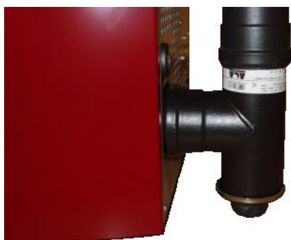
Fig. 49 - Limpieza canal de humos
