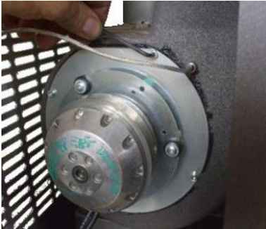
Fig. 50 - Limpieza del aspirador de humos: fase 1
