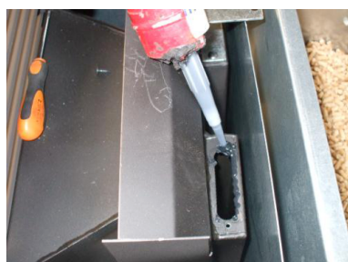
Fig. 60 - Colocación de la silicona
