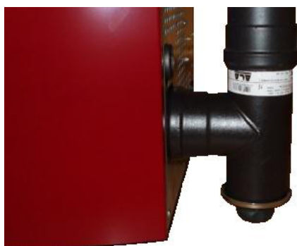
Fig. 49 - Limpeza do canal de fumo
