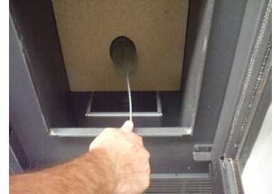
Fig. 45 - Limpieza con escobilla
