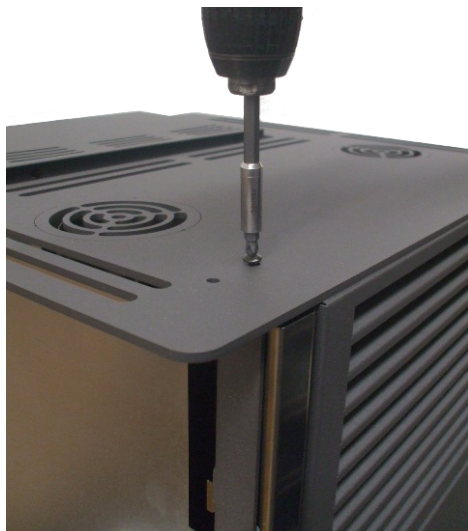
Fig. 19 - Extacción le los tornillos superiores
