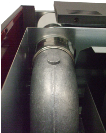
Fig. 33 - Posicionamiento posterior de los tubos
