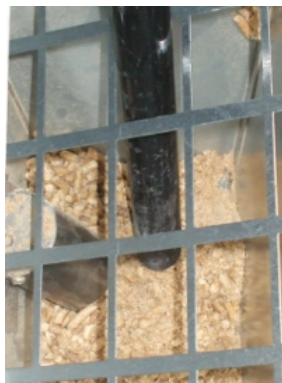
Fig. 46 - Limpieza depósito y coclea
