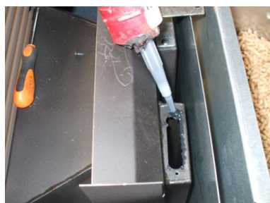
Fig. 60 - Colocação de silicone
