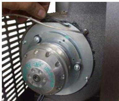
Fig. 50 - Limpeza do aspirador de fumos: fase 1
