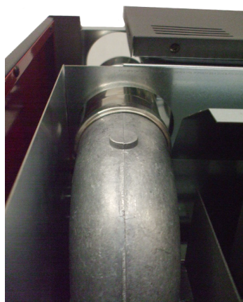
Fig. 33 - Posicionamento tubos posteriores
