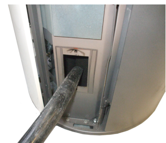
Fig. 64 - Nettoyage du conduit de fumée
