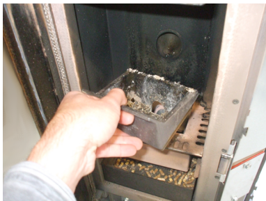
Fig. 35 - Extraction de le brasero
