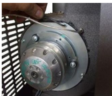
Fig. 45 - Nettoyage de l'aspirateur des fumées: phase 1
