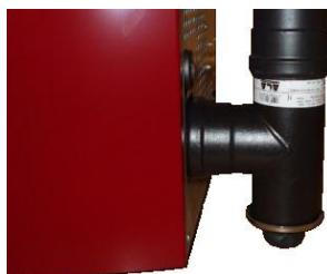
Fig. 44 - Nettoyage du conduit de fumée
