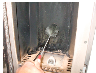
Fig. 40 - Nettoyage avec nettoie-pipes
