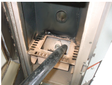
Fig. 38 - Nettoyage l'espace du brasero
