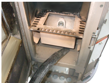
Fig. 39 - Nettoyage l'espace du tiroir à cendre
