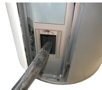
Fig. 55 - Nettoyage du canal
