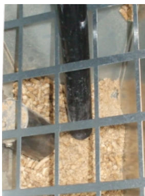
Fig. 41 - Nettoyage réservoir et vis sans fin
