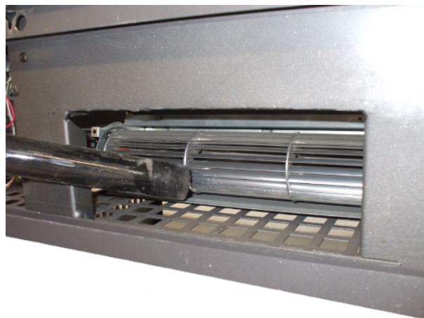
Fig. 49 - Nettoyage de le ventilateur ambiant
