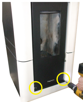
Fig. 22 - Fissaggio cornice
