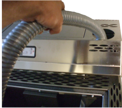
Fig. 31 - Limpeza do canal de fumo
