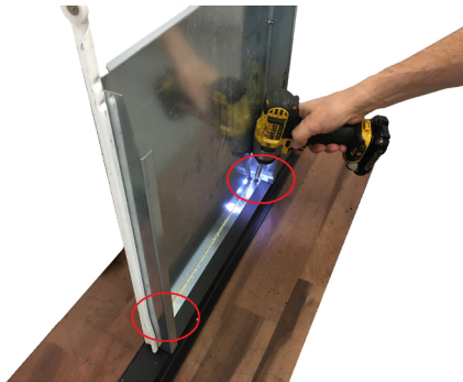
Fig. 36 - Remoção do acabamento frontal
