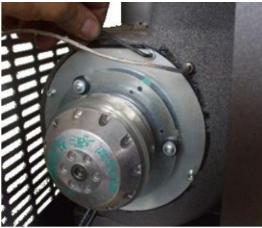
Fig. 50 - Limpeza do aspirador de fumos: fase 1
