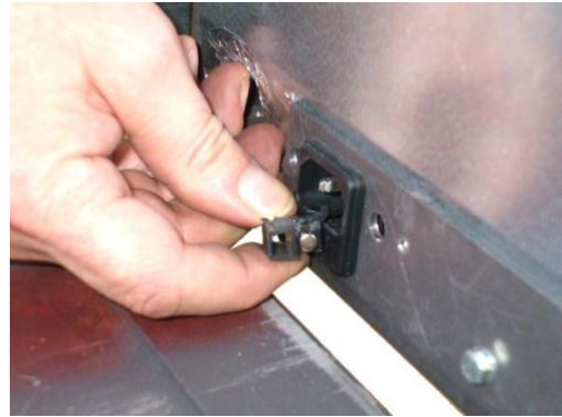
Fig. 64 - Substituição do fusível
