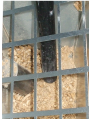
Fig. 47 - Limpeza do reservatório e da rosca sem fim
