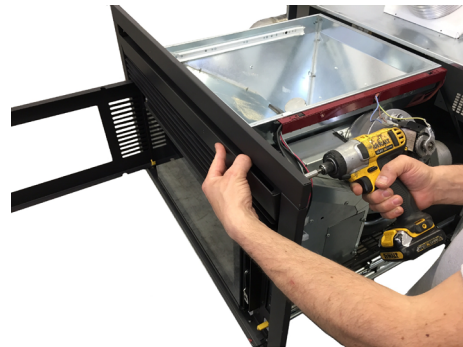
Fig. 37 - Fixação do acabamento frontal
