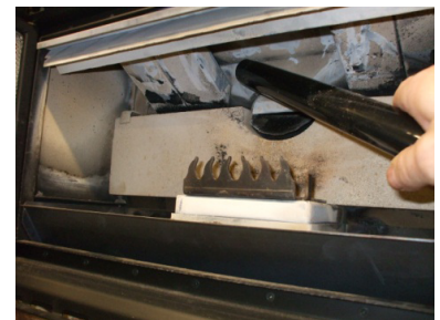
Fig. 46 - Limpeza da parte superior
