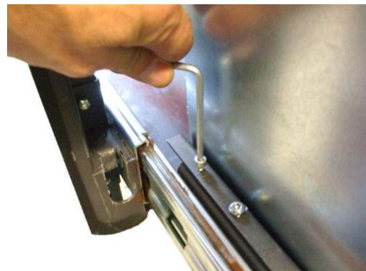
Fig. 15 - Parafuso posterior de fixação da lareira embutida
