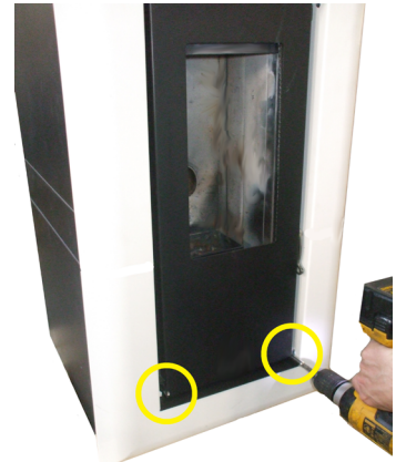
Fig. 38 - Fixação o painel frontal
