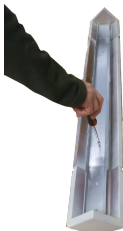
Fig. 26 - Aparafusar o perfil nas majólicas
