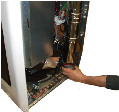
Fig. 82 - Limpeza do canal de fumo
