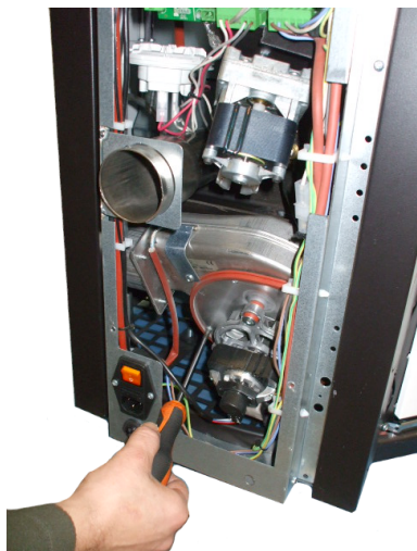
Fig. 84 - Czyszczenie odciaгу dymu: faza 1
