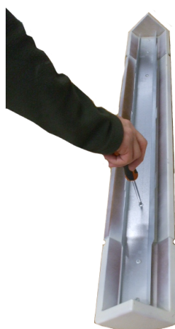
Fig. 26 - Przykręcić profil do majoliki
