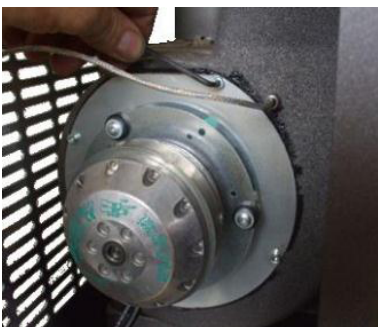
Fig. 35 - Pulizia aspiratore fumi: fase 1
