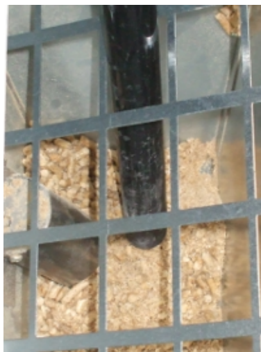
Fig. 31 - Nettoyage réservoir et vis sans fin
