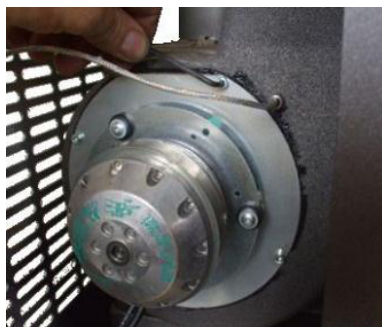
Fig. 35 - Nettoyage de l'aspirateur des fumées: phase 1
