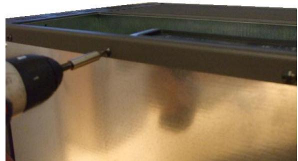
Fig. 15 - Levée les vis derrière
