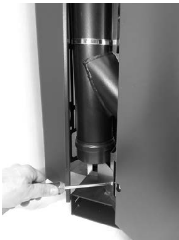
Fig. 65 - Ξεβιδώστε τη βάση του καπακιού
