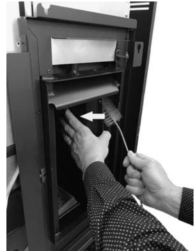
Fig. 68 - Mit einer Rohrreinigungsbürste reinigen
