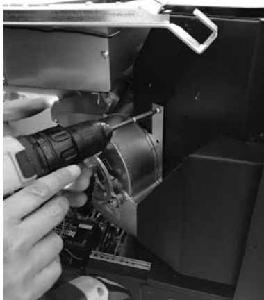
Fig. 37 - Ventilator verwijderen
