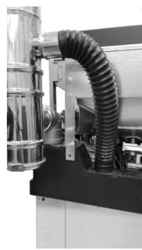
Fig. 77 - Aansluiting verbrandingsluchtslang
