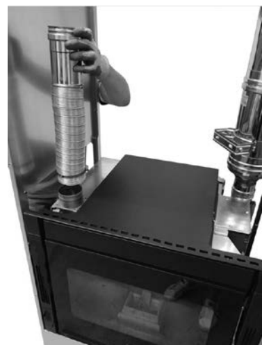
Fig. 60 - Plaatsing van het inbouwelement
