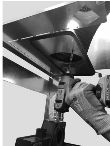
Fig. 65 - Bevestiging flexibele buis
