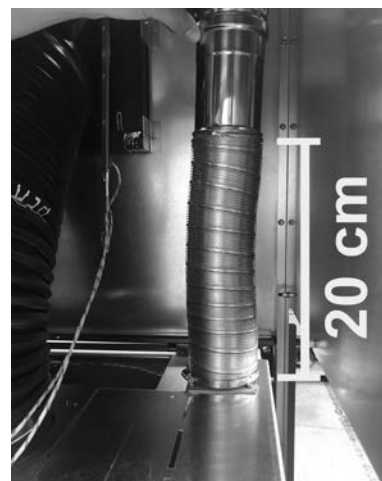
Fig. 48 - Aansluiting buigzame leiding (achteraanzicht van het inzetstuk)
