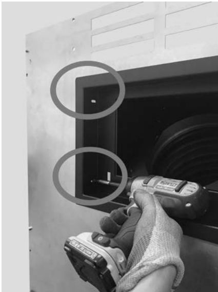
Fig. 66 - Externe bevestiging laadklep
