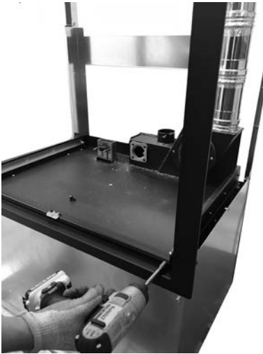
Fig. 72 - Frontale bevestiging
