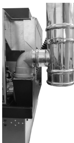
Fig. 76 - Collegamento tubo concentrico
