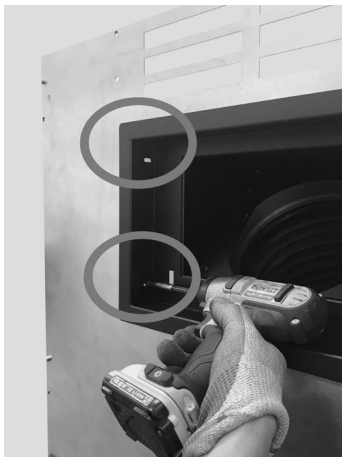
Fig. 66 - Fissaggio esterno botola
