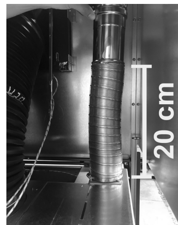
Fig. 48 - Collegamento tubo flessibile (vista posteriore dell'inserto)
