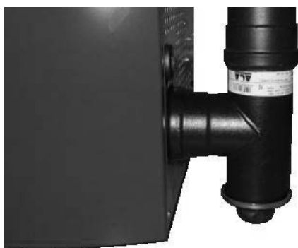
Fig. 40 - Nettoyage du conduit de fumée
