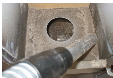
Fig. 37 - Reiniging ruimte aslade
