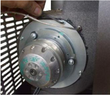
Fig. 46 - Fume fan cleaning: phase 1
