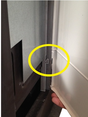
Fig. 21 - Plaatsing van de panelen
