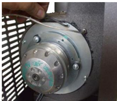
Fig. 50 - Pulizia aspiratore fumi: fase 1
