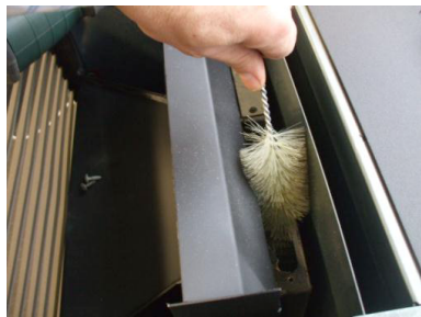
Fig. 59 - Nettoyage du canal
