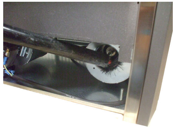
Fig. 56 - Pulizia ventilatore ambiente
