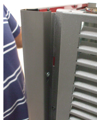
Fig. 22 - Insertion des profilés
