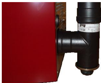
Fig. 49 - Nettoyage du conduit de fumée
