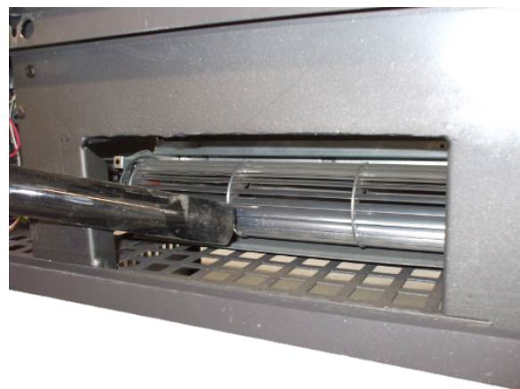
Fig. 47 - Čiščenje ventilatorja za prostor
