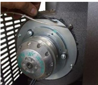
Fig. 43 - Καθαρισμό ανεμιστήρα καυσαερίων : Φάση 1
