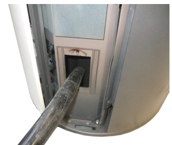
Fig. 62 - Καθαρισμός καναλιών καυσαερίων
