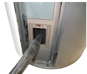
Fig. 53 - Καθαρισμός καναλιών καυσαερίων
