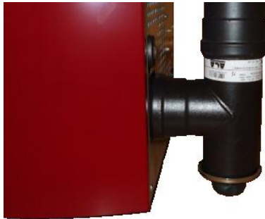
Fig. 42 - Καθαρισμός αγωγού καυσαερίων
