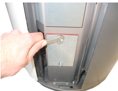
Fig. 51 - Αφαίρεση καλυμμάτων
