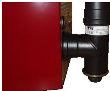
Fig. 42 - Limpeza do canal de fumo
