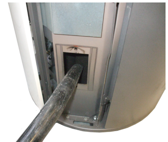
Fig. 62 - Limpeza canais
