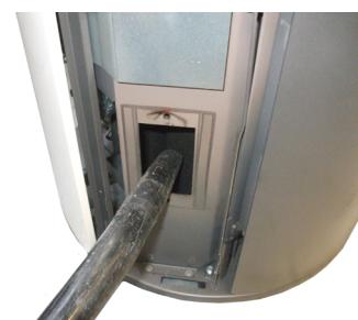
Fig. 53 - Limpeza canais
