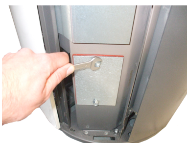
Fig. 51 - Remoção das tampas
