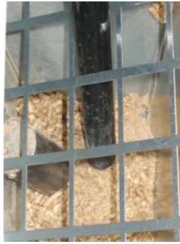
Fig. 39 - Limpeza do reservatório e da rosca sem fim
