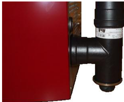
Fig. 39 - Limpeza do canal de fumo
