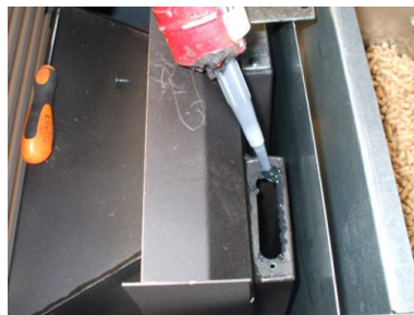
Fig. 46 - Colocação de silicone
