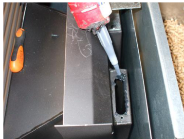
Fig. 46 - Colocación de la silicona
