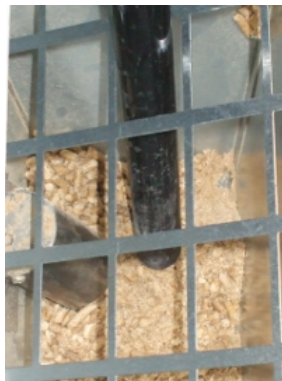
Fig. 36 - Limpeza do reservatório e da rosca sem fim
