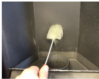
Fig. 34 - Limpieza con escobilla
