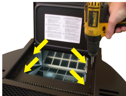
Fig. 68 - Dæksel 2 fjern skrue
