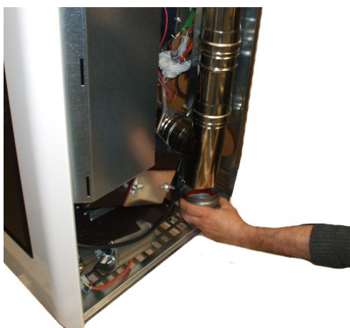
Fig. 82 - Rengøring af røgkanal
