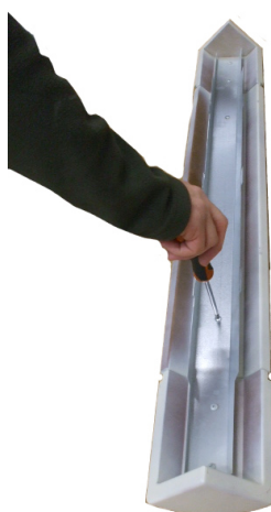
Fig. 26 - Spænd profilen på keramikken
