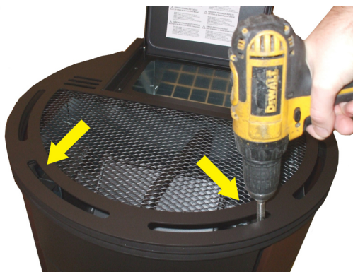
Fig. 67 - Dæksel 1 fjern skrue
