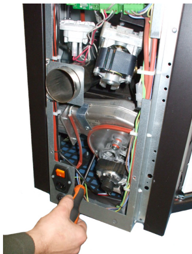
Fig. 84 - Rengøring af røgsuger: trin 1
