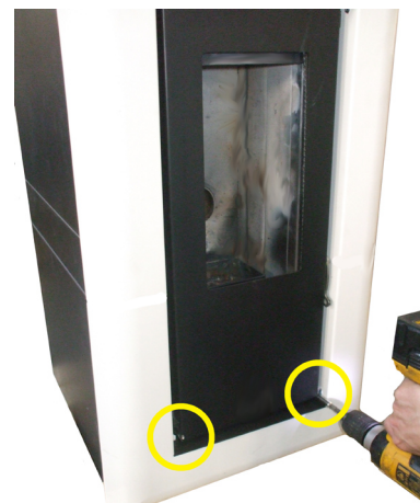
Fig. 38 - Fastgøring af ramme
