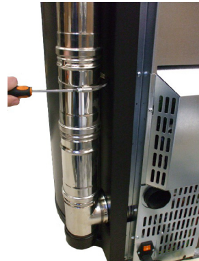
Fig. 83 - Canale da fumo (Sfera 3 Plus, Sfera 3 , Globe, Elise 3 Plus)
