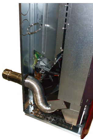
Fig. 47 - Posizionamento tubi per canalizzazione posteriore
