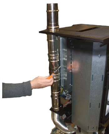
Fig. 45 - Posizionamento tubi per canalizzazione superiore
