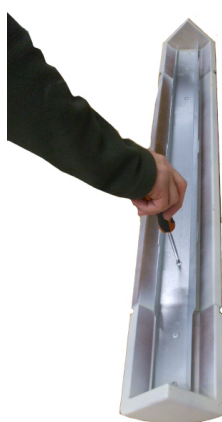
Fig. 26 - Avvitare profilo alle maioliche
