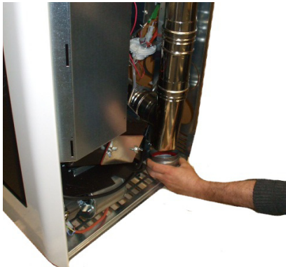
Fig. 82 - Pulizia canale da fumo
