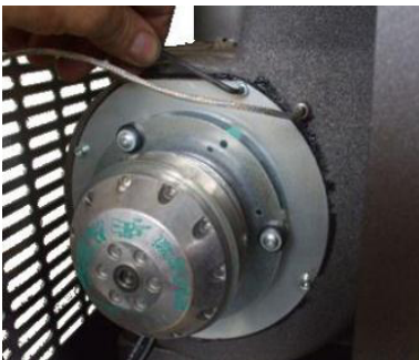
Fig. 35 - Καθαρισμό ανεμιστήρα καυσαερίων : Φάση 1
