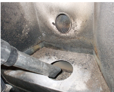
Fig. 28 - Καθαρισμός εσωτερικού μέρους δοχείου καύσεως
