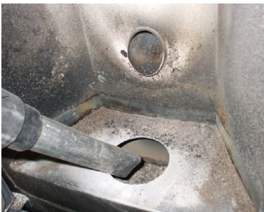
Fig. 28 - Rengøring af fyrfadsrum
