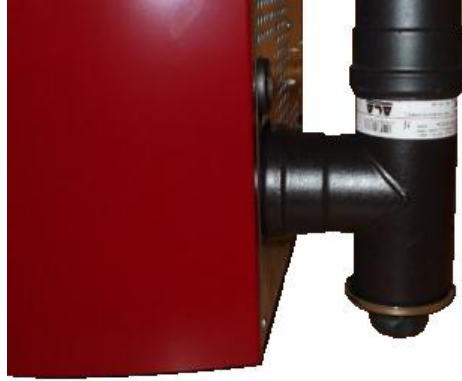
Fig. 34 - Καθαρισμός αγωγού καυσαερίων
