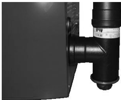
Fig. 35 - Czyszczenie czopucha
