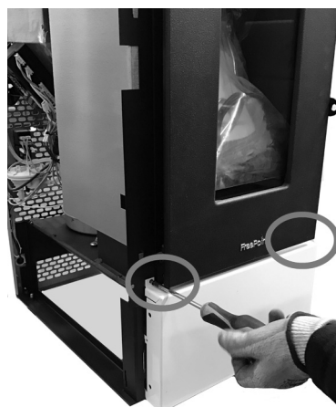
Fig. 21 - Umocować płytę przednią
