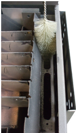
Fig. 46 - Nettoyage du canal
