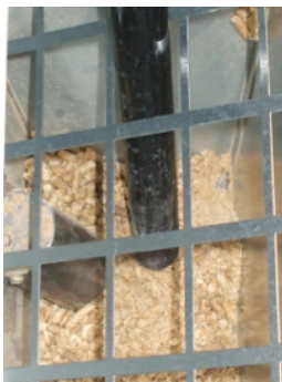
Fig. 36 - Nettoyage réservoir et vis sans fin
