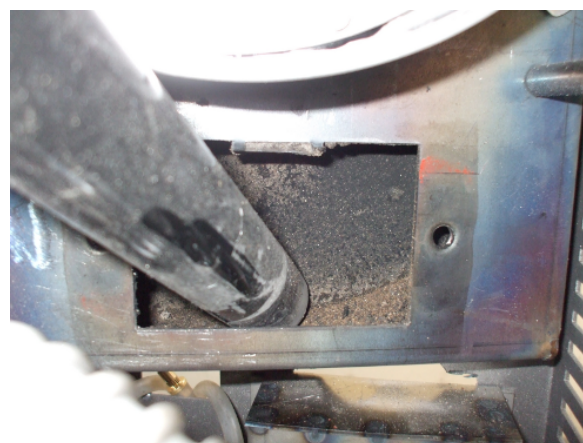
Fig. 38 - Nettoyage de la chambre des fumées
