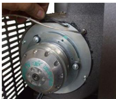
Fig. 40 - Nettoyage de l'aspirateur des fumées: phase 1
