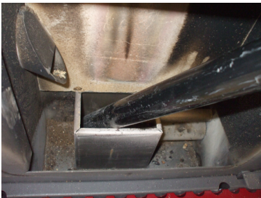
Fig. 33 - Nettoyage l'espace du brasero
