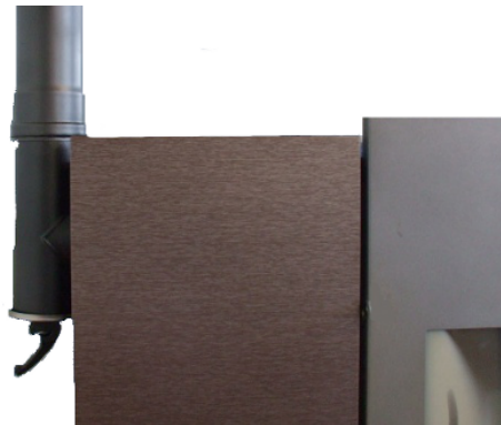
Fig. 46 - Limpieza canal de humos
