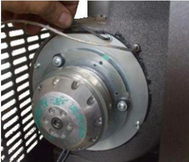
Fig. 47 - Limpeza do aspirador de fumos: fase 1
