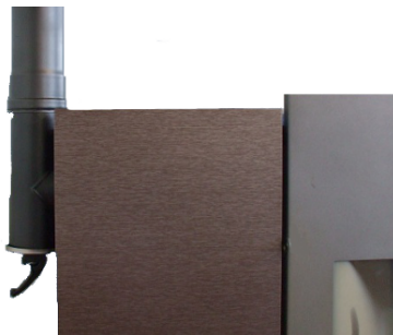
Fig. 46 - Limpeza do canal de fumo
