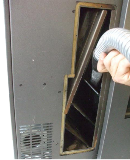
Fig. 45 - Limpieza cámara de humos
