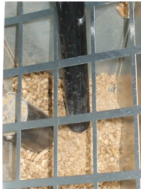
Fig. 42 - Limpieza depósito y coclea
