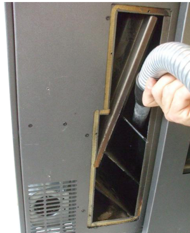
Fig. 45 - Limpeza da câmara de fumos
