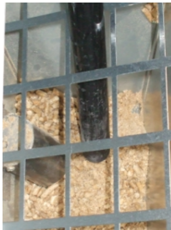
Fig. 42 - Limpeza do reservatório e da rosca sem fim
