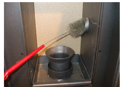
Fig. 41 - Limpieza con escobilla
