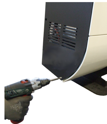
Fig. 22 - Bevestiging onderaan van de panelen
