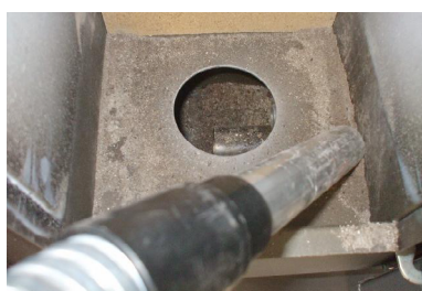
Fig. 39 - Reiniging ruimte aslade
