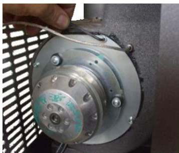
Fig. 47 - Fume fan cleaning: phase 1
