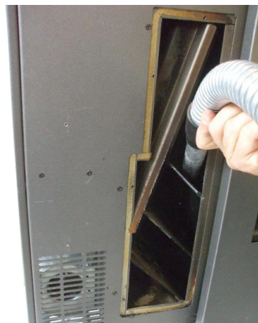
Fig. 45 - Reiniging rookkassenkamer
