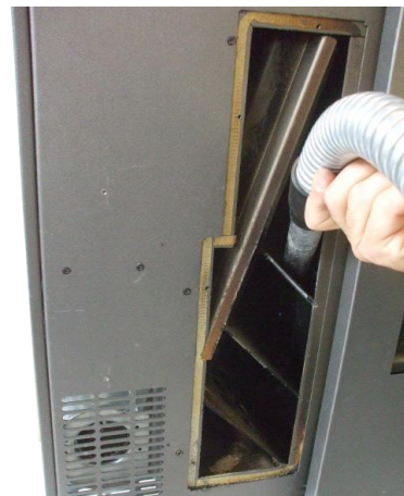
Fig. 44 - Καθαρισμός θάλαμου καυσαερίων
