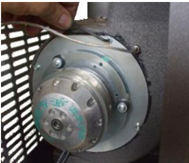
Fig. 46 - Καθαρισμό ανεμιστήρα καυσαερίων : Φάση 1
