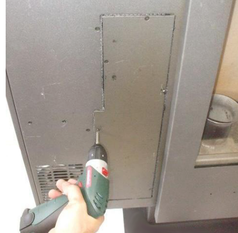
Fig. 42 - Αφαίρεση πάνελ
