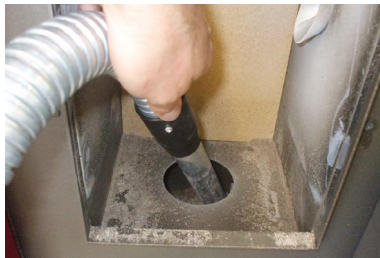
Fig. 38 - Καθαρισμός εσωτερικού μέρους δοχείου καύσεως
