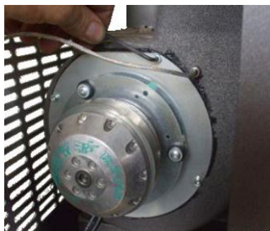
Fig. 50 - Καθαρισμό ανεμιστήρα καυσαερίων : Φάση 1
