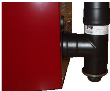
Fig. 49 - Καθαρισμός αγωγού καυσαερίων
