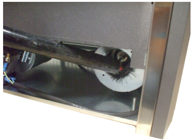
Fig. 56 - Καθαρισμός ανεμιστήρα δωματίου
