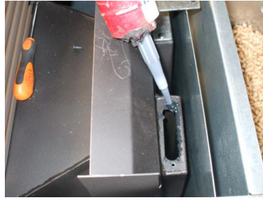
Fig. 60 - Τοποθέτηση σιλικόνης
