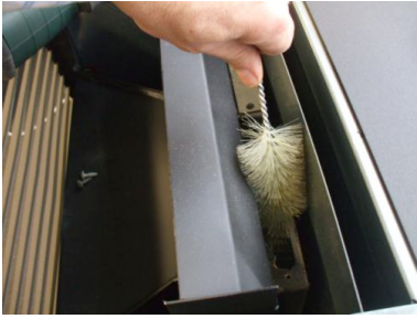
Fig. 59 - Καθαρισμός καναλιού καυσαερίων
