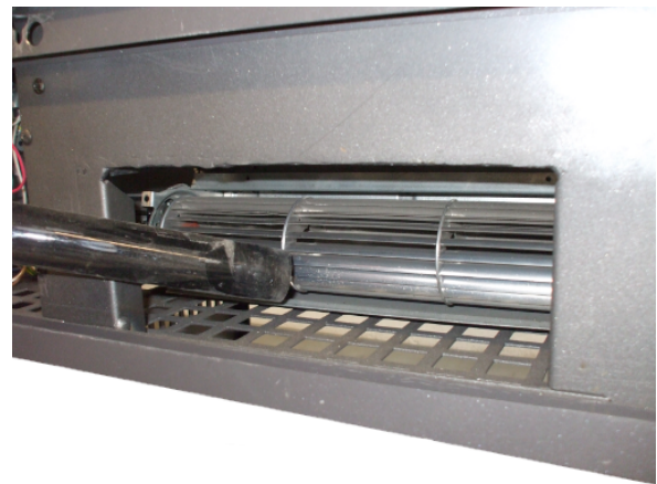
Fig. 47 - Room fan cleaning
