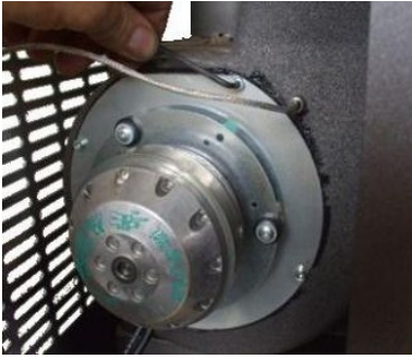
Fig. 43 - Fume fan cleaning: phase 1
