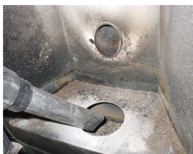
Fig. 33 - Rengøring af fyrfadsrum
