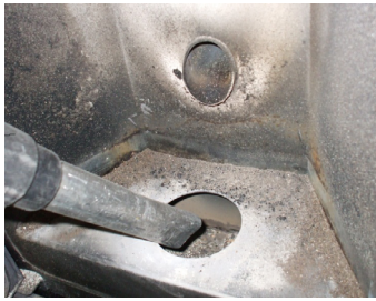
Fig. 33 - Καθαρισμός εσωτερικού μέρους δοχείου καύσεως
