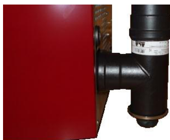
Fig. 39 - Rengøring af røgkanal
