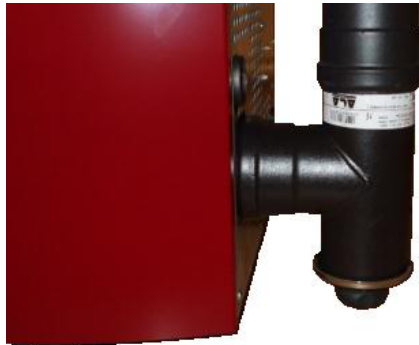
Fig. 39 - Καθαρισμός αγωγού καυσαερίων
