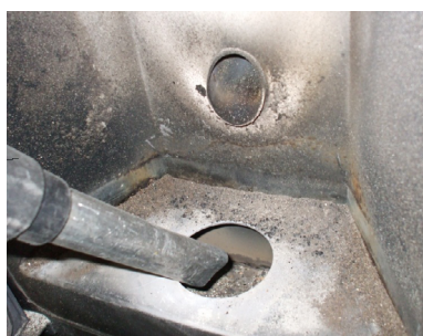
Fig. 33 - Reiniging ruimte vuurpot
