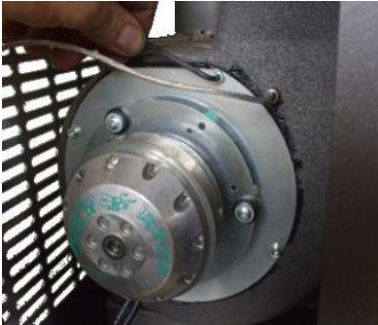
Fig. 40 - Fume fan cleaning: phase 1
