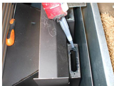
Fig. 46 - Aanbrengen siliconenkit
