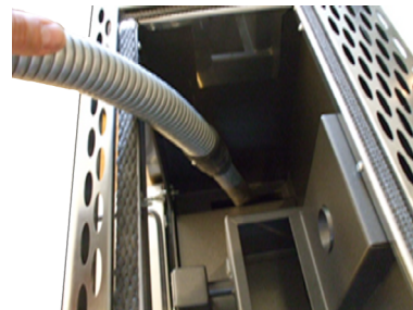
Fig. 22 - Limpeza da câmara de combustão
