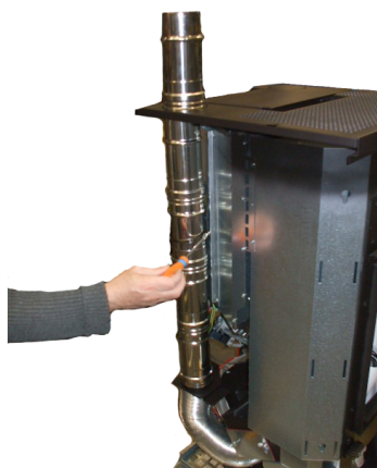
Fig. 48 - Positionnement des tubes supérieurs
