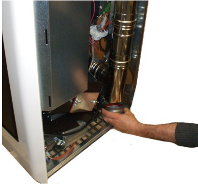
Fig. 85 - Nettoyage du collecteur des fumées
