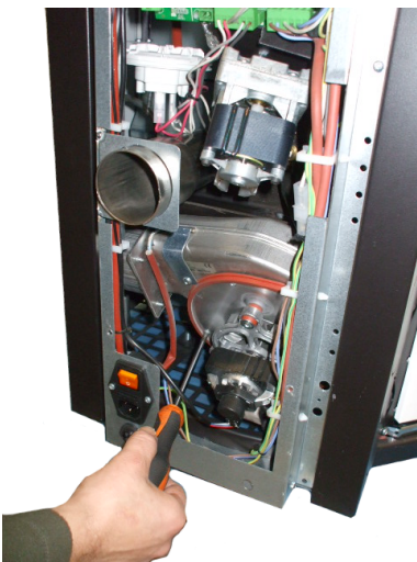
Fig. 87 - Nettoyage de l'aspirateur des fumées: phase 1
