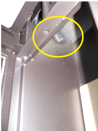
Fig. 79 - Passages des fumées
