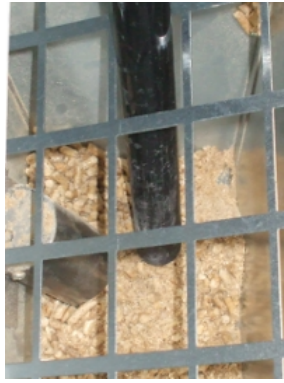
Fig. 63 - Nettoyage réservoir et vis sans fin
