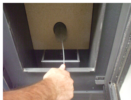
Fig. 62 - Nettoyage avec nettoie-pipes
