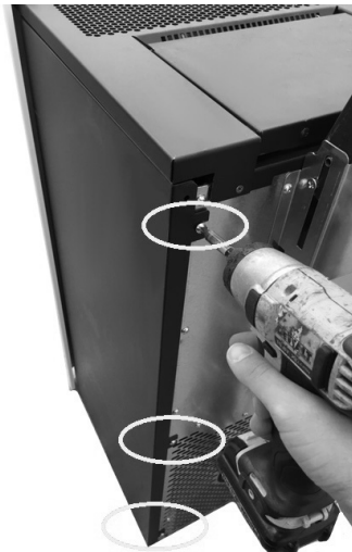
Fig. 26 - Draai de schroeven los
