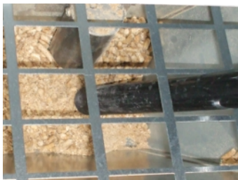
Fig. 33 - Pulizia serbatoio e coclea
