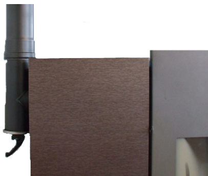
Fig. 36 - Pulizia canale da fumo
