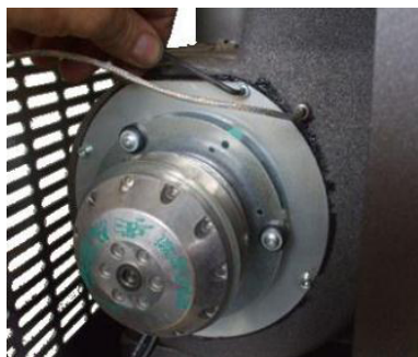
Fig. 37 - Czyszczenie odciaгу dymu: faza 1
