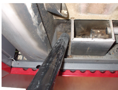
Fig. 31 - Czyszczenie miejsca na szufladę na popiół
