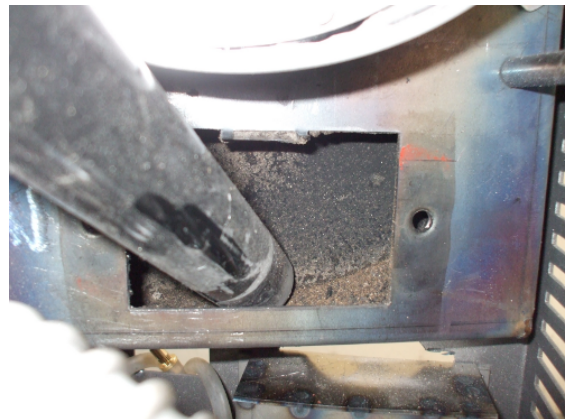
Fig. 35 - Czyszczenie komory dymu
