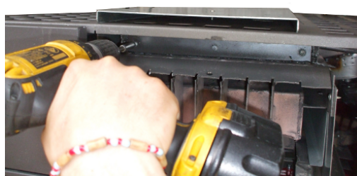
Fig. 42 - Wyjmowanie zamknięcia
