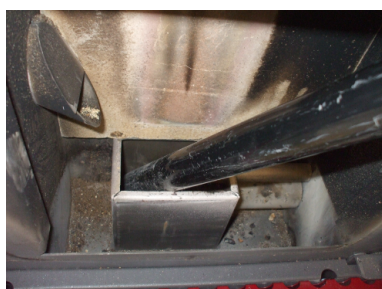
Fig. 30 - Czyszczenie miejsca na ruszt paleniskowy
