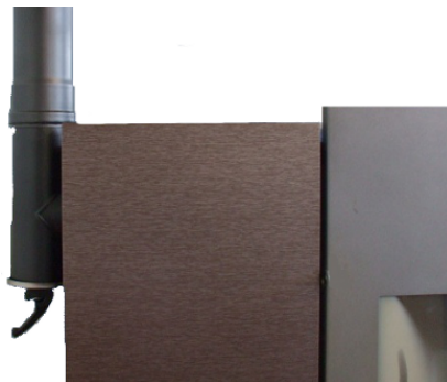
Fig. 36 - Καθαρισμός αγωγού καυσαερίων
