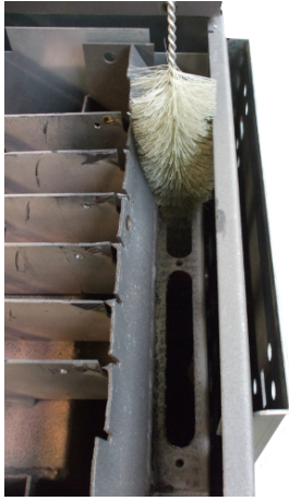
Fig. 43 - Καθαρισμός καναλιών καυσαερίων
