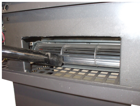
Fig. 40 - Καθαρισμός ανεμιστήρα δωματίου
