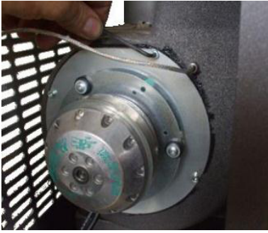
Fig. 37 - Καθαρισμό ανεμιστήρα καυσαερίων : Φάση 1
