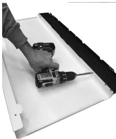
Fig. 37 - Przymocować kolorową boczną ściankę
