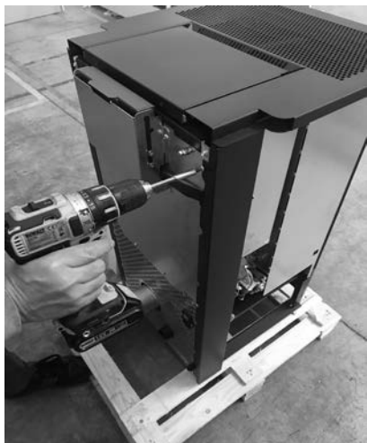
Fig. 36 - Verwijder het zwarte profiel
