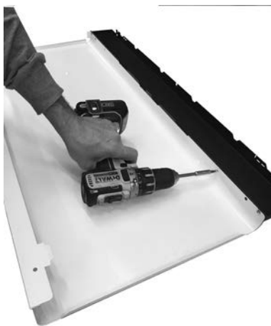
Fig. 37 - Fastgør det farvede sidestykke
