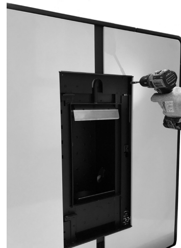
Fig. 40 - Befestigen der Verkleidung
