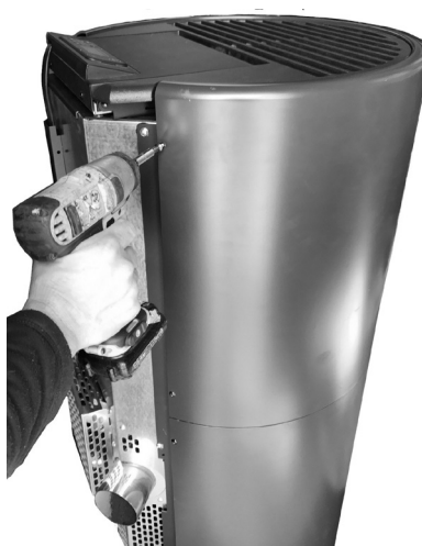
Fig. 66 - Odstranjevanje zadnjih vijakov
