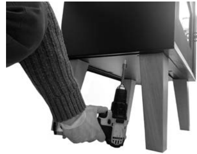
Fig. 21 - Befestigung des Ofens
