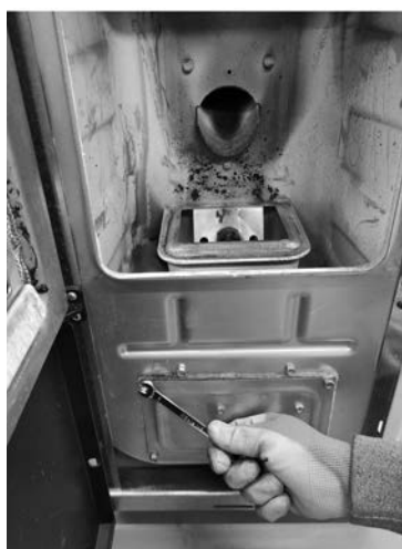
Fig. 30 - Retirer les vis
